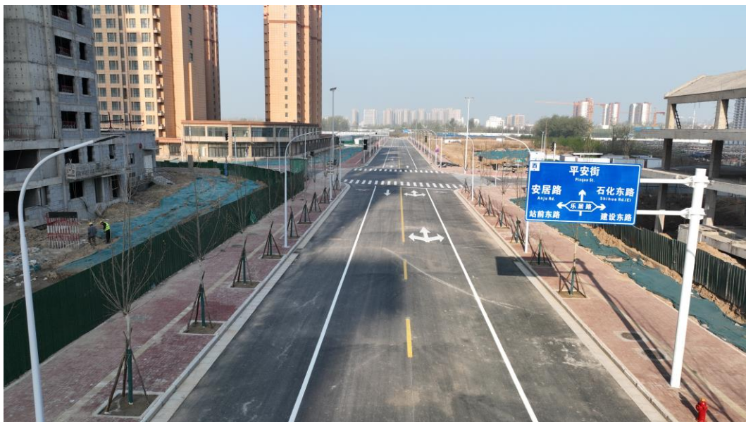
图为：乐居路（站前路-石化路）竣工照片
