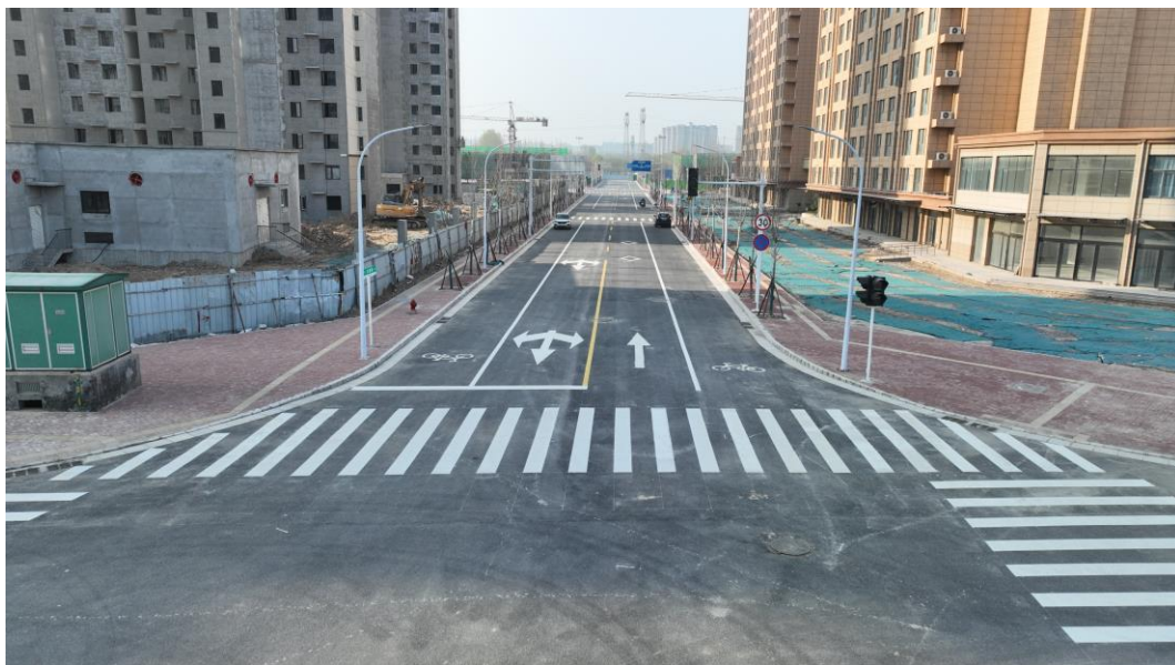
图为：花园路（平安街-玉门路）竣工照片
