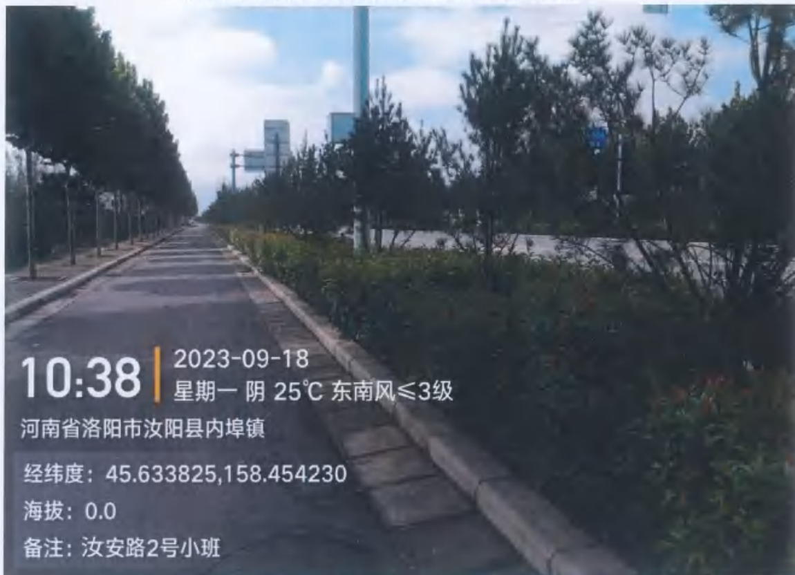
汝阳县生态廊道汝安路绿化项目验收现场照片
