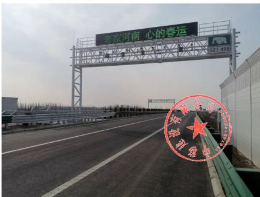
图2. K60处现场情况
