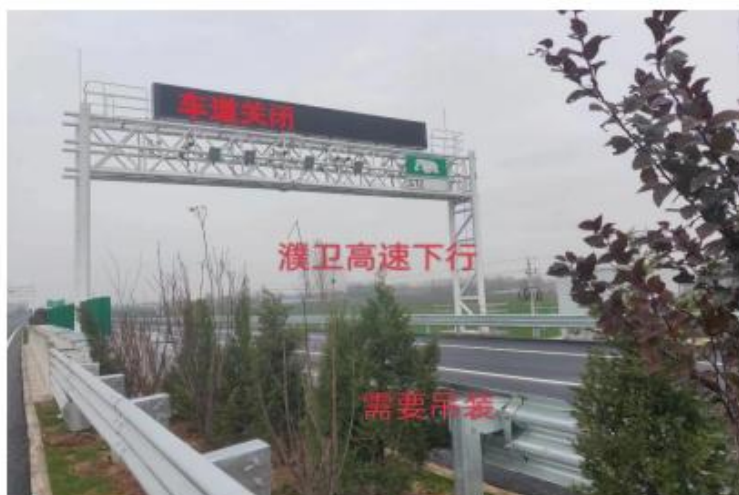
图1. K38处现场情况
