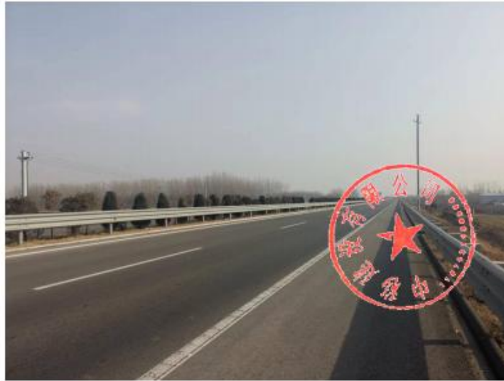
图4. K25处现场情况
